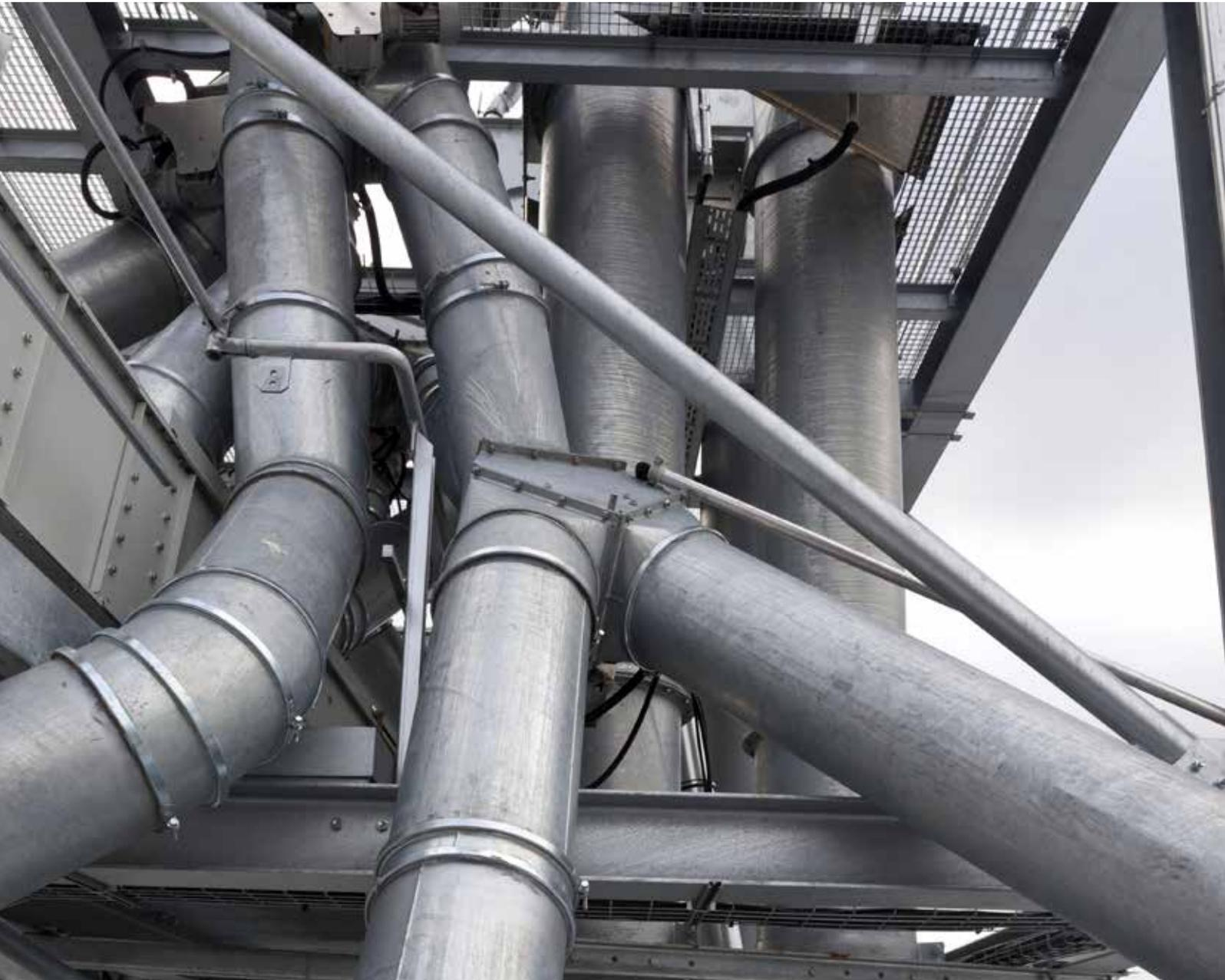
Lauf-Rohrmaterial, Klappkasten, TKF-Schieber, Siloschieber
